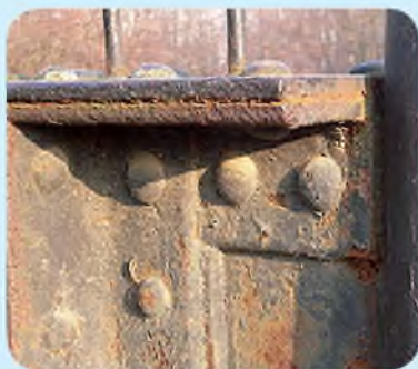
Мал. 131. Заклепкове з'єднання
